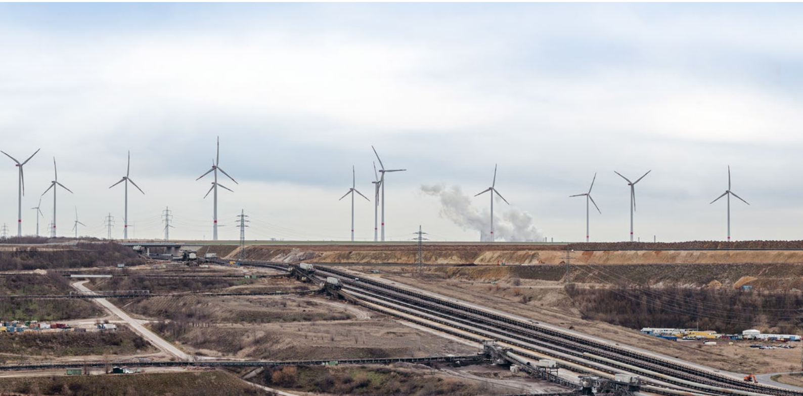
Windkraftanlagen über der Grube des Braunkohletagebaus Garzweiler in Nordrhein-Westfalen.
